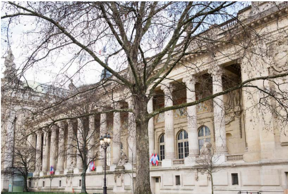
Figure 19 Vue de la façade Est du Grand Palais aujourd'hui © N. Krief
